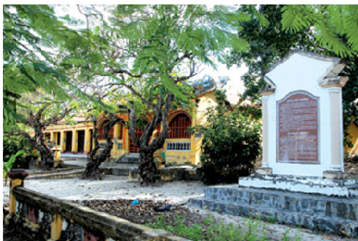
Đình làng Đức Nghĩa, phường Đức Nghĩa, thành phố Phan Thiết
